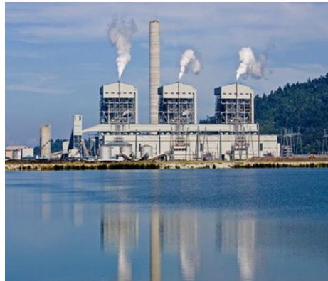
โรงไฟฟ้าถ่านหิน จ.กระบี่
